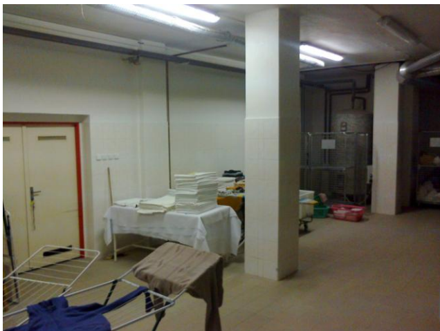
Obrázek 19: Prostory výstavby fitness centra Zdroj: Vlastní zpracování
