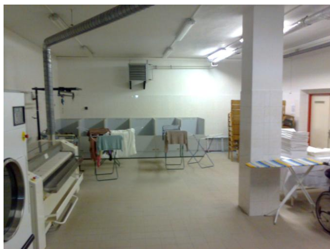
Obrázek 20: Prostory výstavby fitness centra Zdroj: Vlastní zpracování
