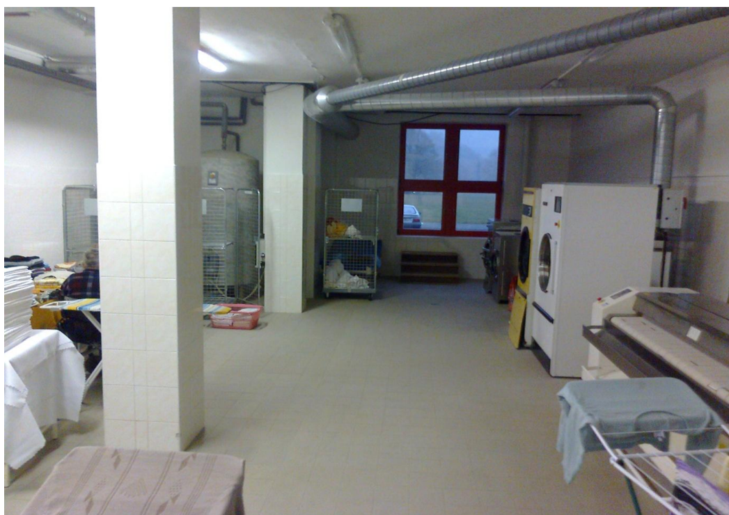
Obrázek 18: Prostory výstavby fitness centra Zdroj: Vlastní zpracování
