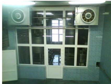
Abb. 12: Luftventilation in der Gärkammer
