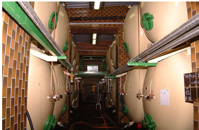
Abb. 15: Blick auf den Tanks im Lagerkeller (12)
