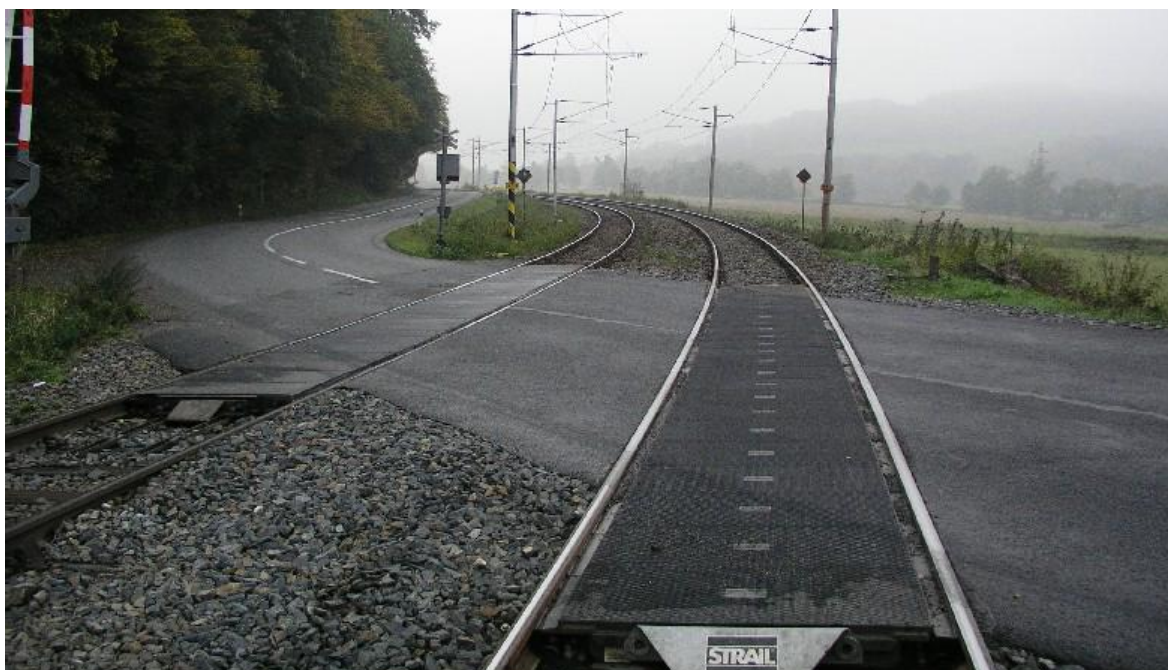
Obr. 10 Pohled na železniční přejezd ve dne
