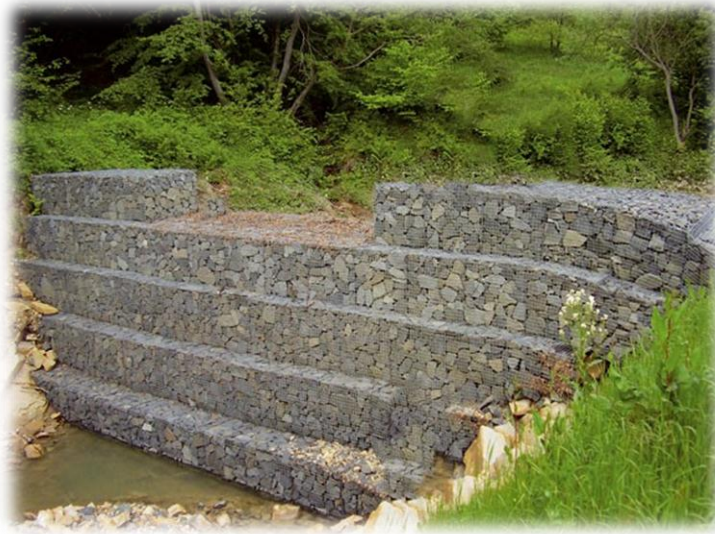
Obr. 18. Polder postavený priamo na toku potoka [16]
