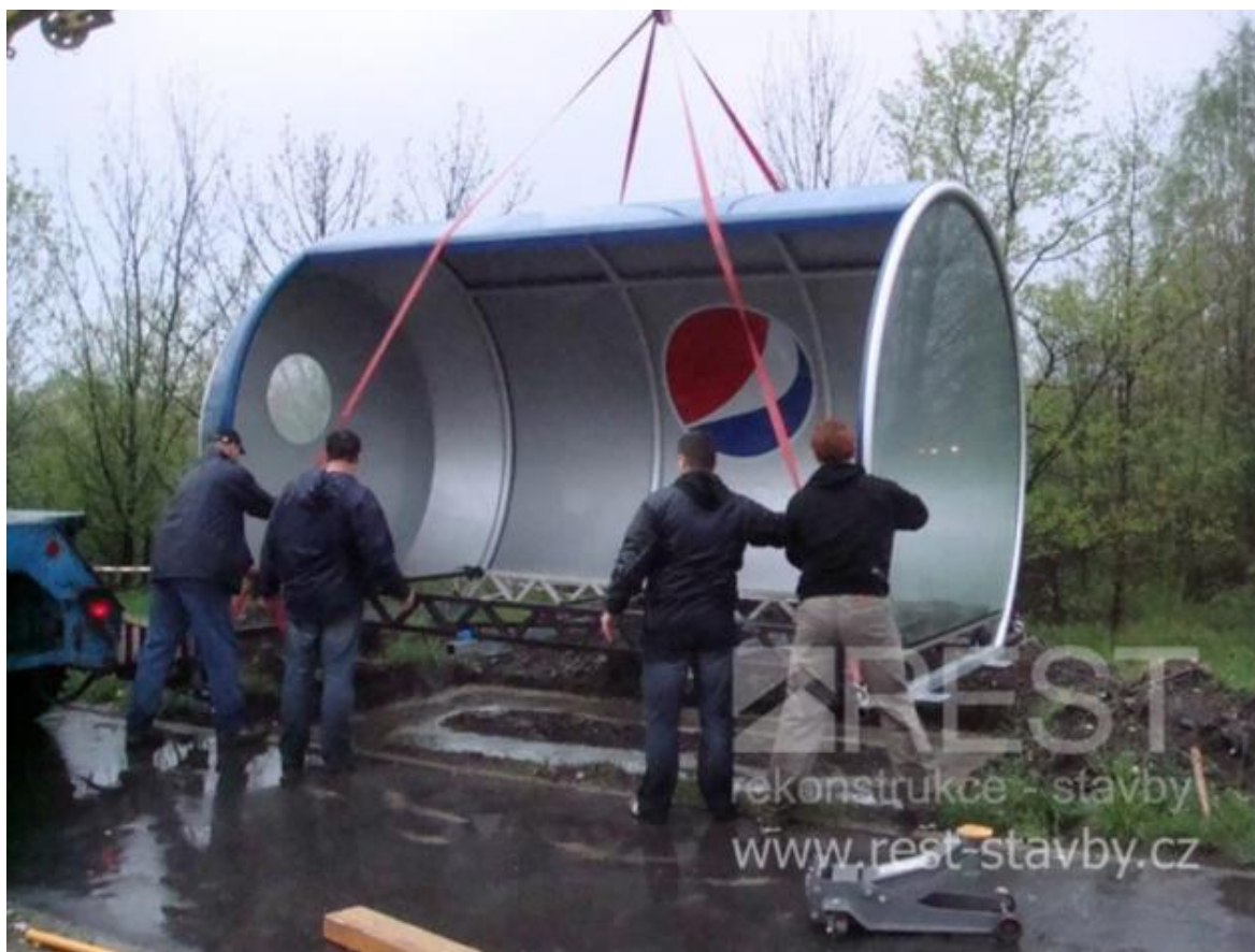
Obrázek 36: Pepsi zastávka Plechovka – instalace
