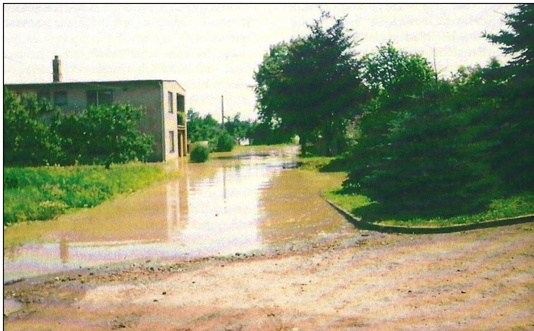
Obrázek 22. Povodně v červenci 1997 – zaplavení rodinného domu Horových [29]
