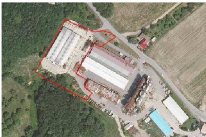
Obr. 3: Bývalý zemědělský areál Kudlov [45]
