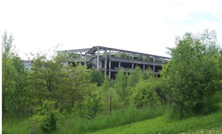
Fotopříloha 10: Betonový skelet na Jižních Svazích nenápadně zarůstá zelení.
