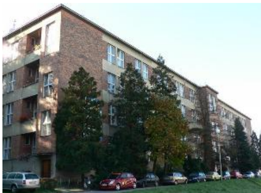
Obr. 11: Budova vědeckotechnického parku před rozsáhlou rekonstrukcí [42]
