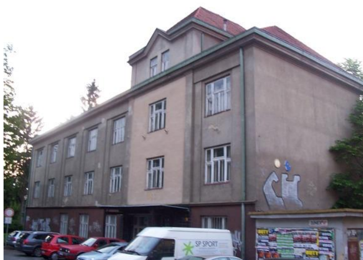
Fotopříloha 9: Opuštěná budova bývalého okresního soudu v samém centru Zlína.
