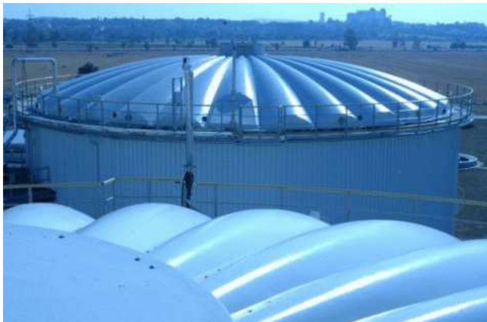
Obr. 10. Sklolaminát – zastřešení ČOV [16]
