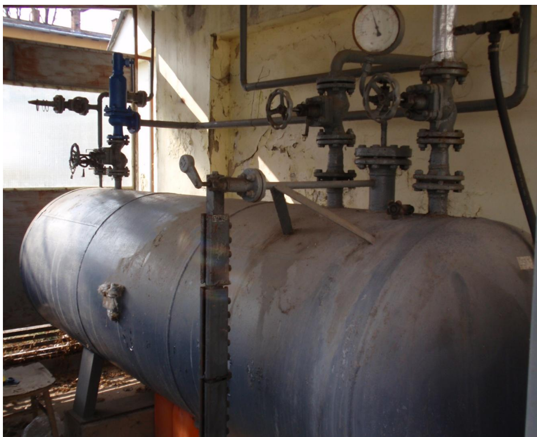
Obr. 2. Nadzemní nádrž v objektu pivovaru s 1000 kg amoniaku
