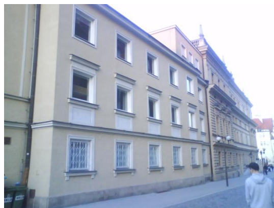
Obrázek 12 Jižní strana přístavby
