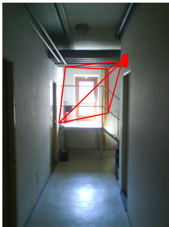
Obrázek 21 PIR detektor snímající vstup
