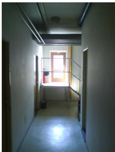
Obrázek 19 Vstup ze střechy
