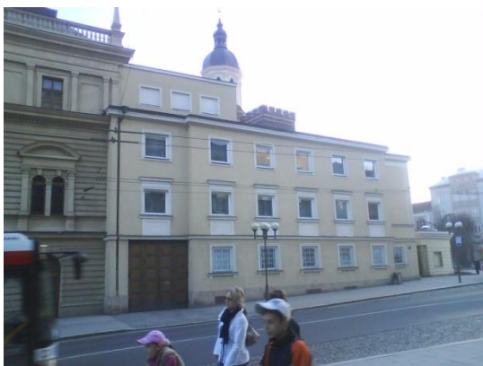
Obrázek 11 Dřevěná vrata (rampa) a okna
