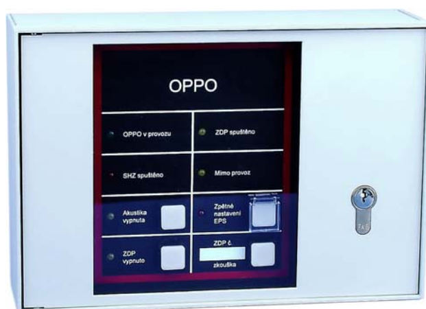
Obr. 17 Obslužné pole požární ochrany [8]
