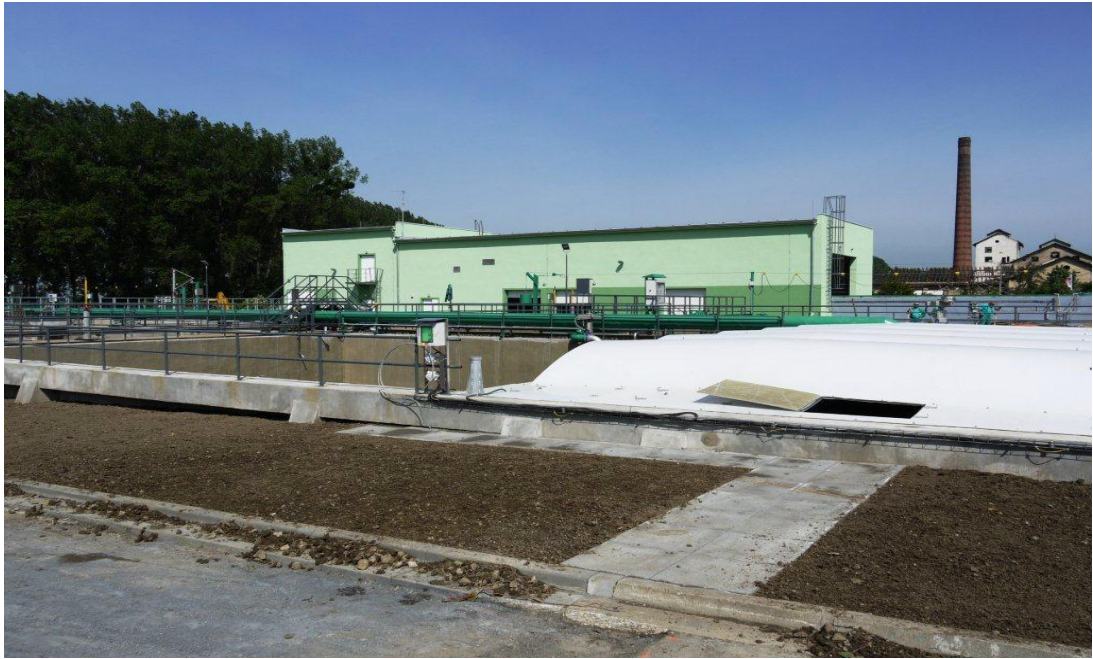
Obr. P 3 Čistírna odpadních vod Hulín [Zdroj: Fotografie společnosti]
