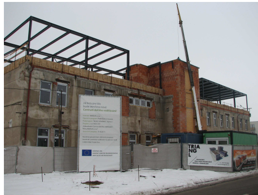
Obr. č. 3: Rekonstrukce ŠS
