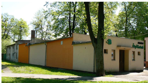
Obr. 16 – Současný stav objektu
