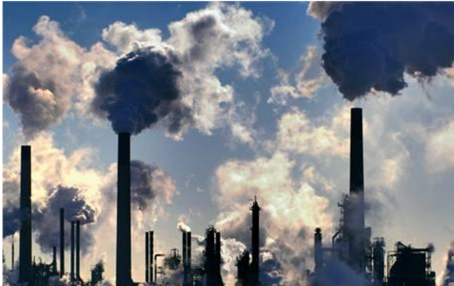
Obr. 27 Komíny spaloven odpadů [16]
