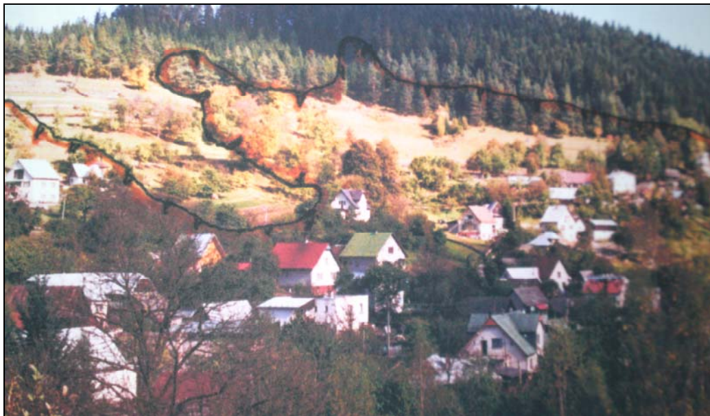
Obr. 16. Znázornenie svahovej deformácie v obci Petrovice - časť Setechov z roku 1993. [17]
