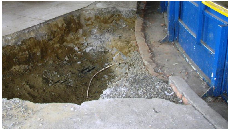
Obr. č. 12 Detailnější záběr potrubí
