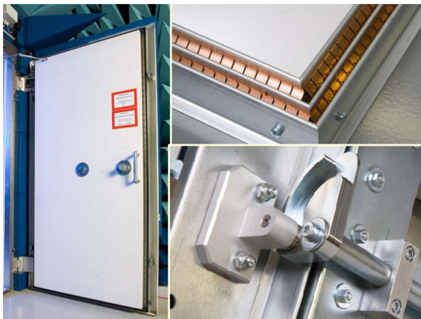
Obrázek 17 Manuální stíněné dveře, detail na nože s beryliovým těsněním [8]
