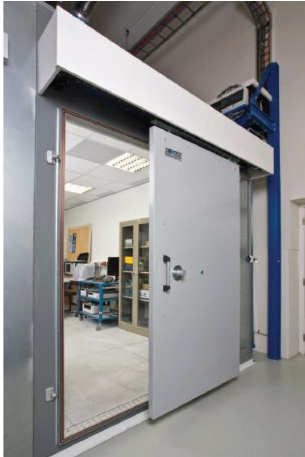
Obrázek 18 Automatické posuvné stíněné dveře [8]
