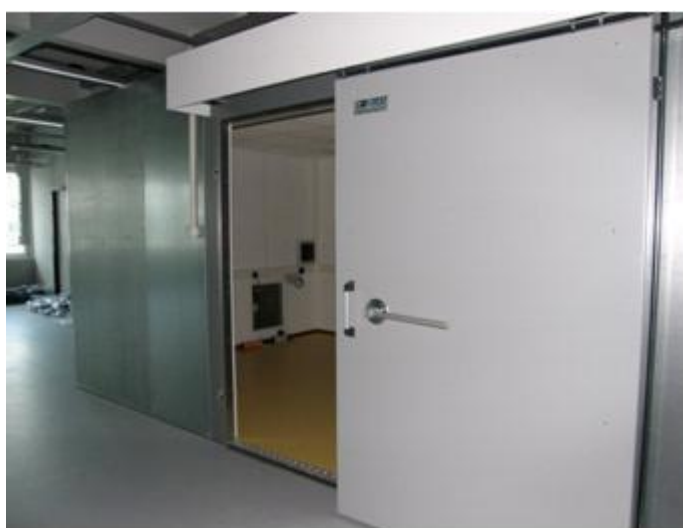
Obrázek 37 Manuální posuvné dveře [8]
