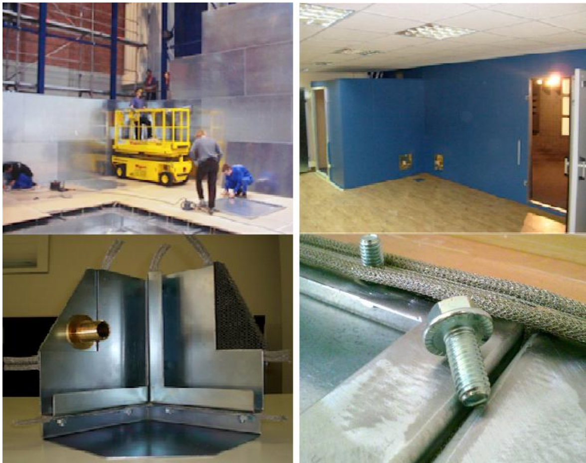
Obrázek 13 Konstrukce stíněné komory [8]
