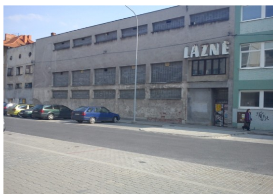
Obr. 7. Budova bývalých lázní
