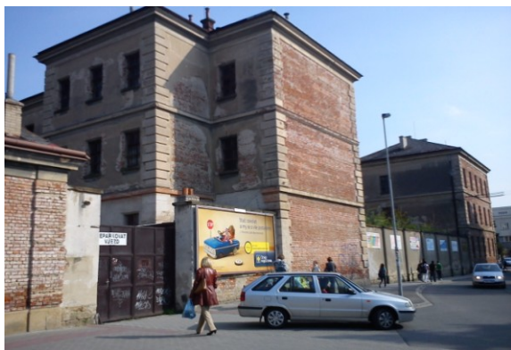
Obr. 6. Budova bývalé věznice
