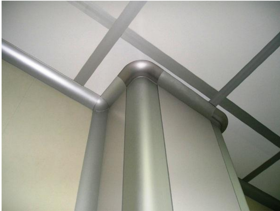
Obr. 11 Zaoblení stěn a stropního systému (hliníkové provedení) [12]
