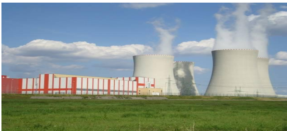
Obr. 3 Sklad vyhořelého paliva jaderné elektrárny Temelín[10]
