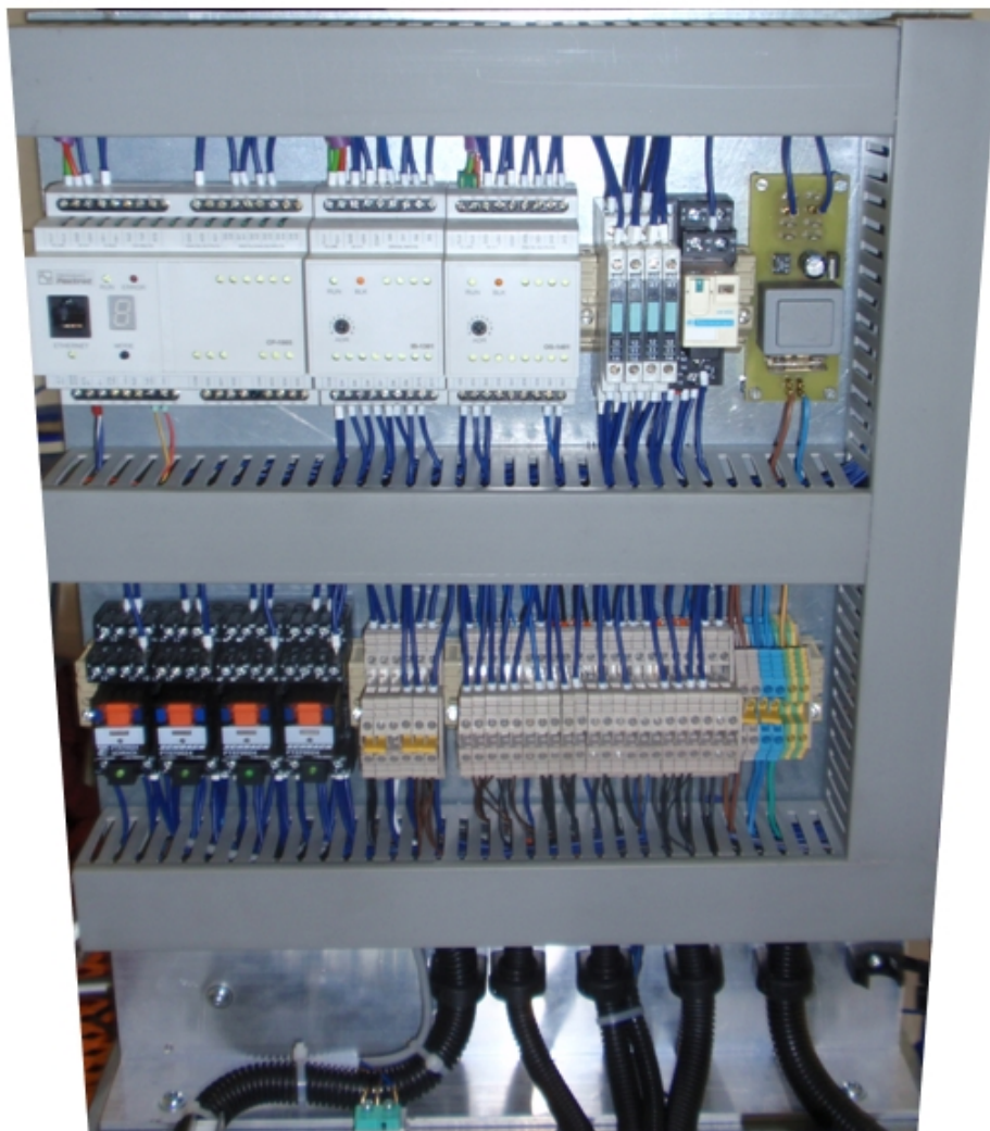
Obrázek 35 – Hlavní panel s osazenou elektronikou
