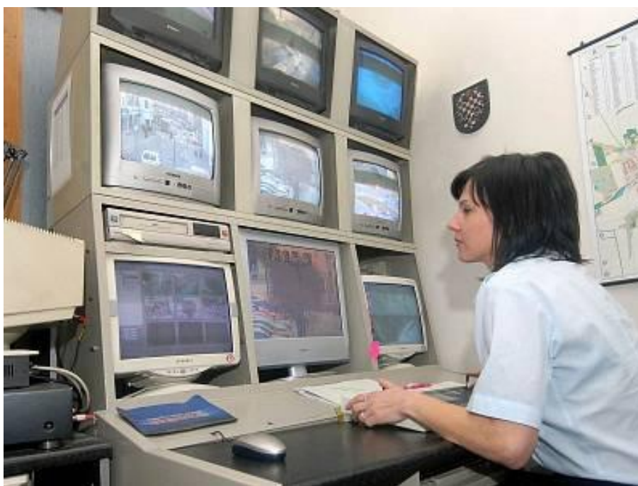
Obr. č. 20 Dohledové centrum[30]
