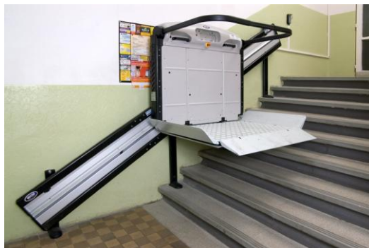
Obr.č. 1: Schodišťová plošina
