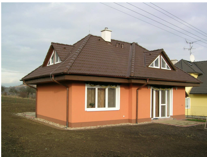
Obr. 6: Dokončená stavba rodinného domu [18]
