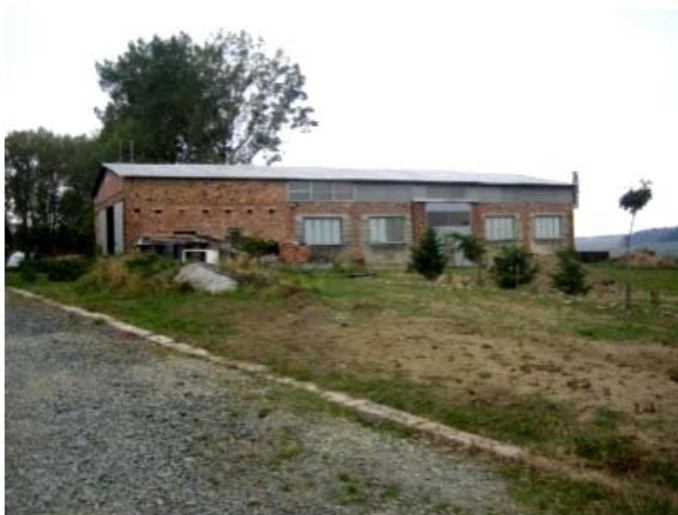
Prvek 3: (východní pohled)
