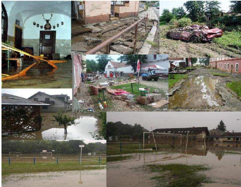
Obr. 3. ukázka škod po opadnutí vody II. [29].
