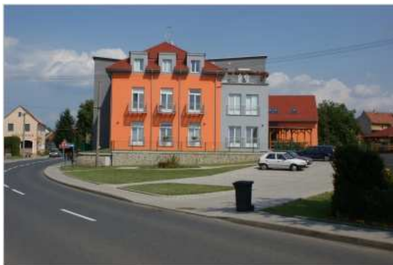
Obr. 4 Dům s chráněnými byty Nedachlebice
