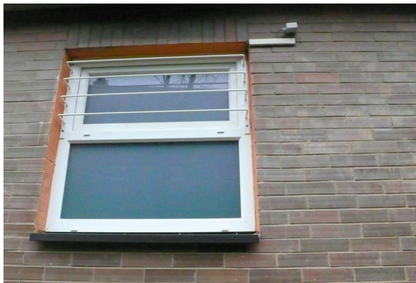
Obr. 25. Zadní strana objektu, okno sklepa.
