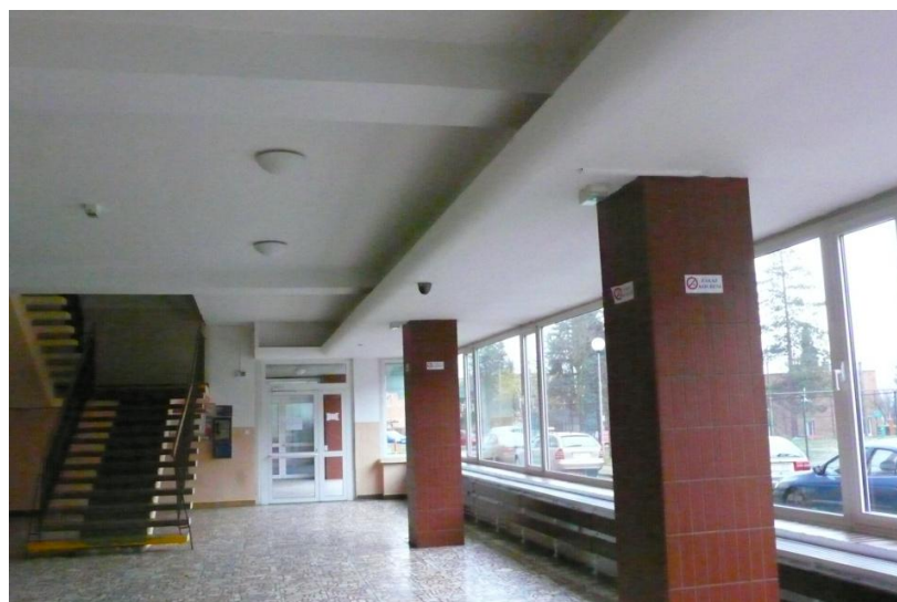
Obr. 13. Kamera umístěná na stropě v přízemí.
