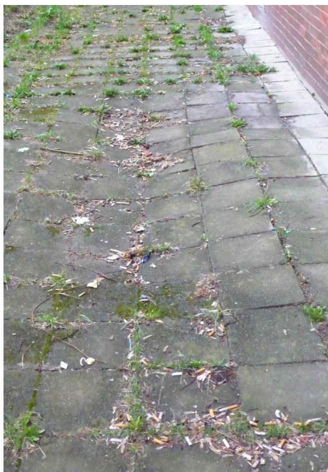
Obr. 26. Zadní strana objektu, nepořádek vyhazující obyvateli domu z oken.
