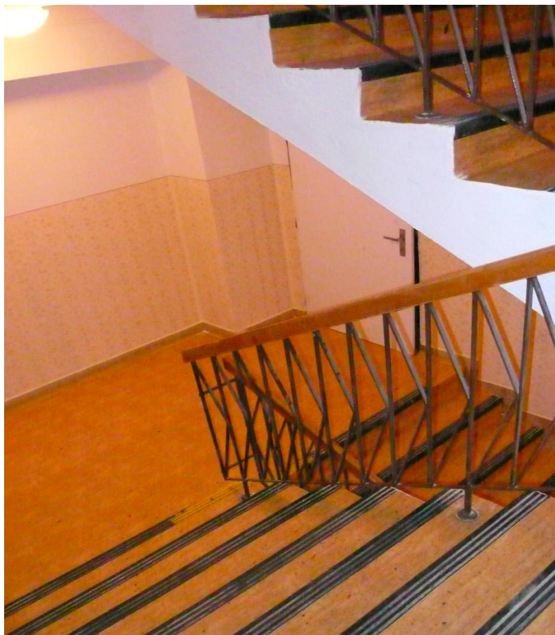
Obr. 37. Schodiště se vstupem na chodbu.
