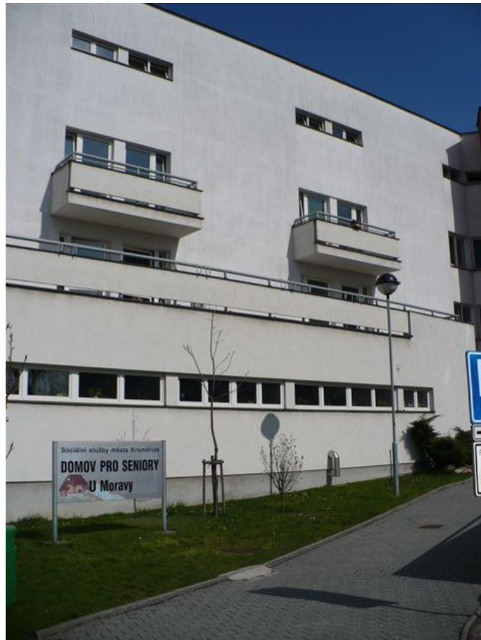
Obr. 1: pohled na budovu zařízení
