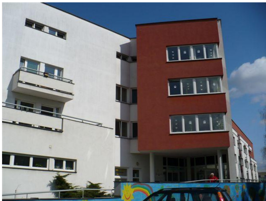
Obr. 2: pohled na budovu zařízení boční
