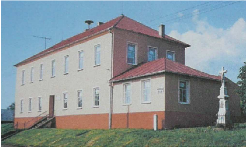
Obrázek 10 Současný vzhled budovy [21]
