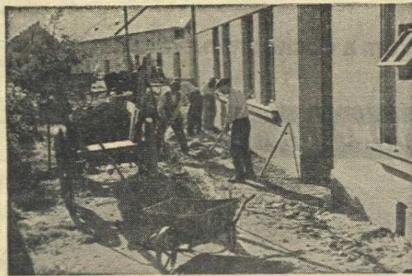
Budování chodníků v Sazovicích.
