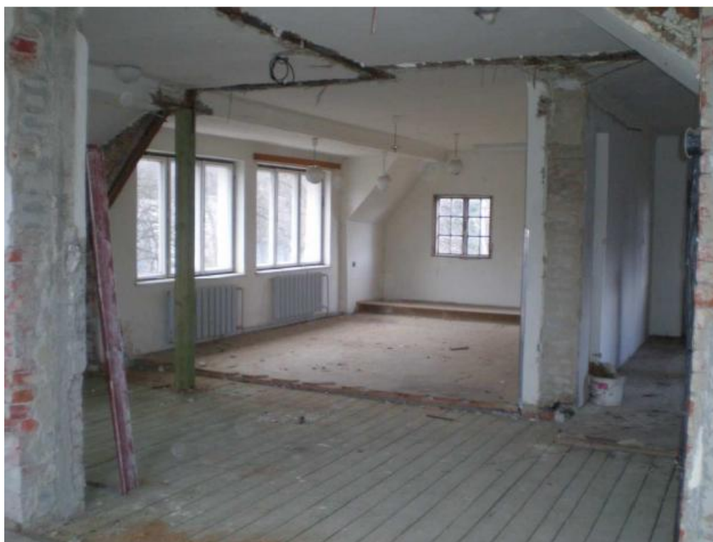
Stávající interiér objektu
