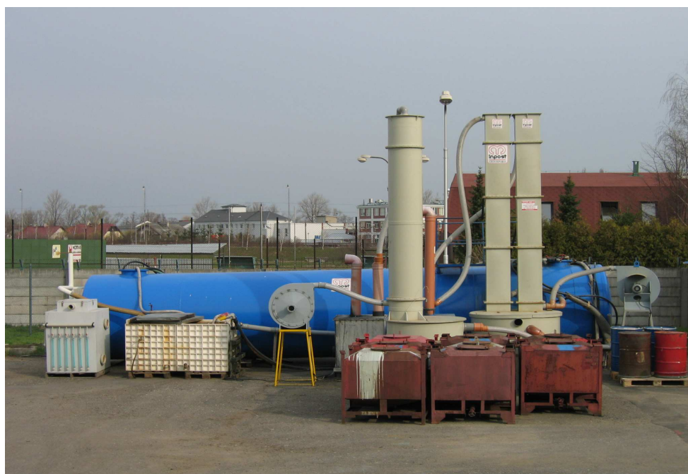
Obr.č.15 : Sanační jednotka v prostoru Balakomu
