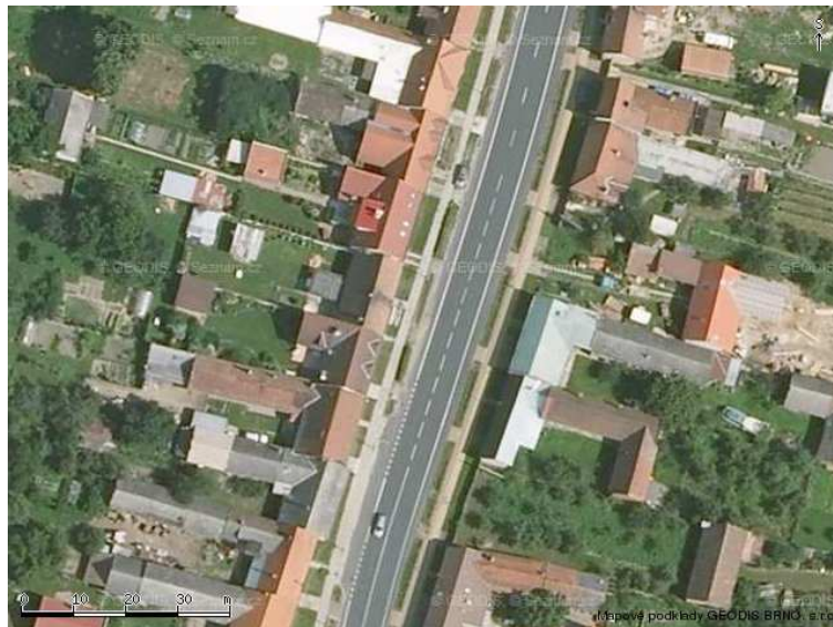
Obrázek 9 - Silniční průtah obcí Spytihněv [12]
