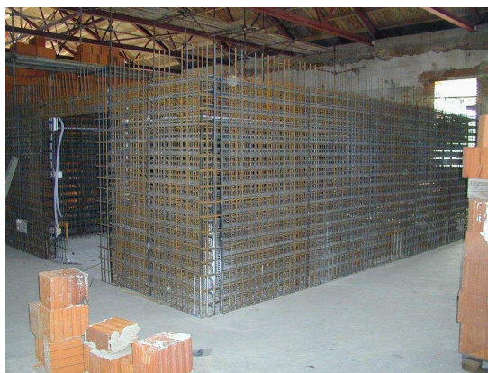
Obr. 4. Stavba monolitického komorového trezoru
