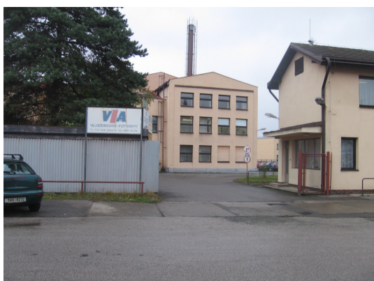
Obr. 7 Hlavní vchod do areálu
