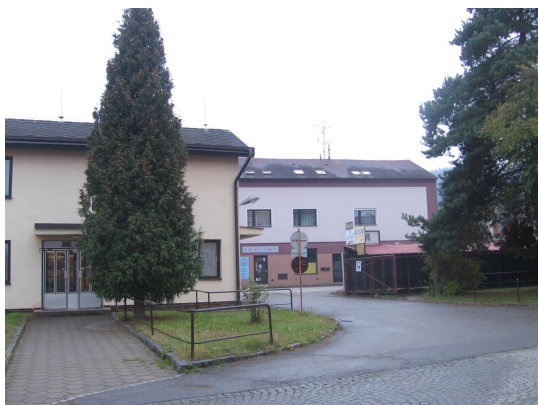
Obr. 9 Prostor hlavního vchodu do areálu
