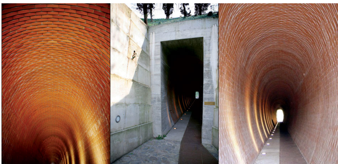
Obr. 18 Pasáž v Jelením příkopu Obr. 19 Pasáž v Jelením příkopu Obr. 20 Pasáž v Jelením příkopu
