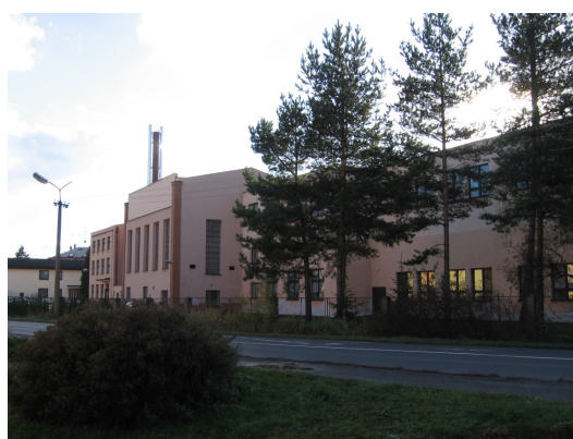
Obr. 6 Silnice směr Hronov – Náchod
