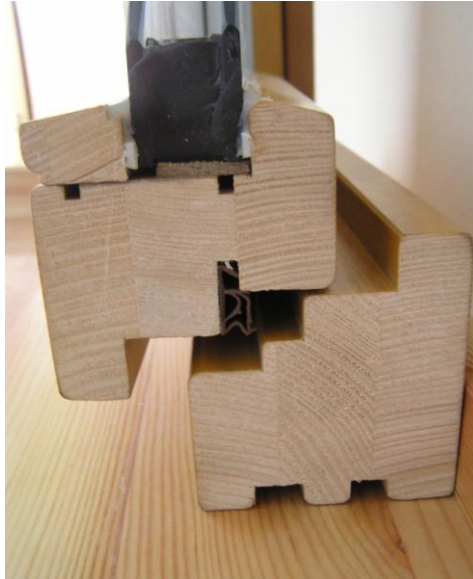
Obr. 10. Opracovaný lepený hranol
