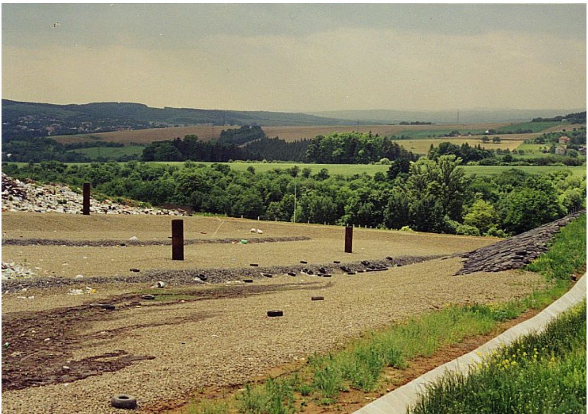
Obrázek 10: odplyňovací studny na III., ještě aktivní, etapě skládky
