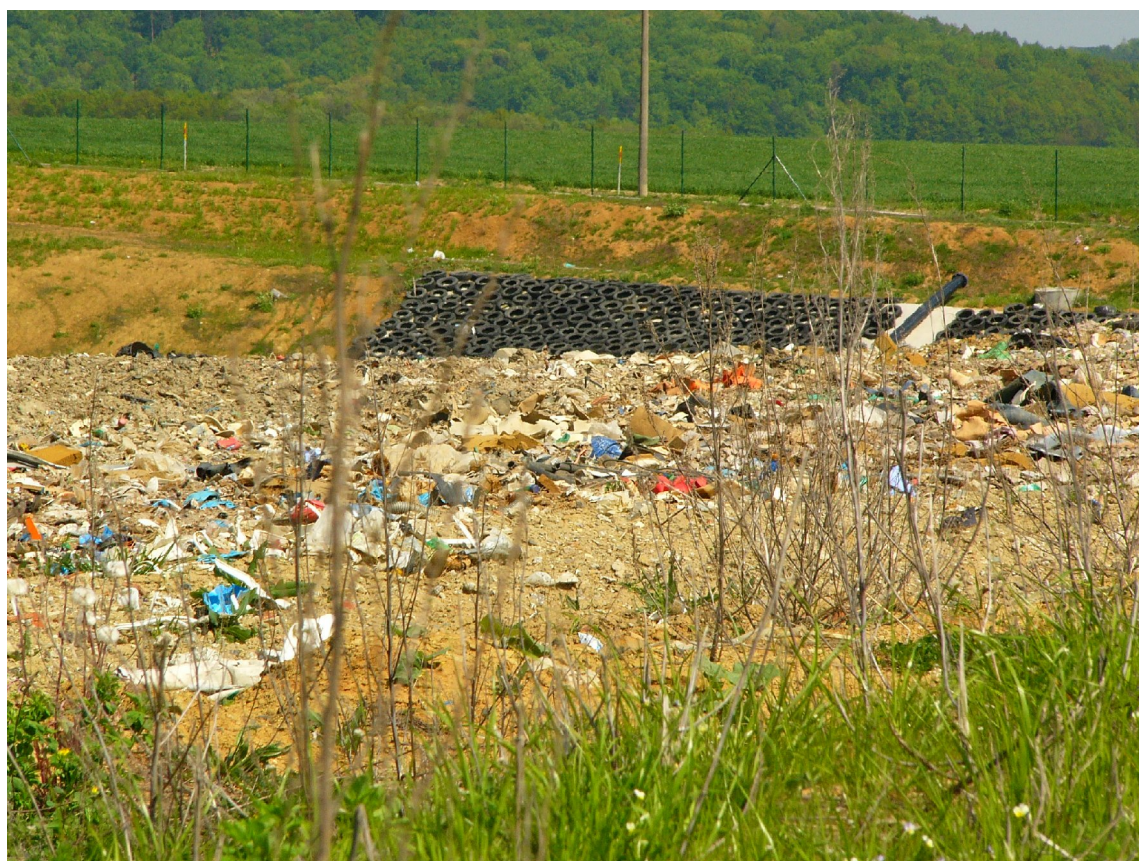
Obrázek 11: sběrné potrubí na III. etapě
