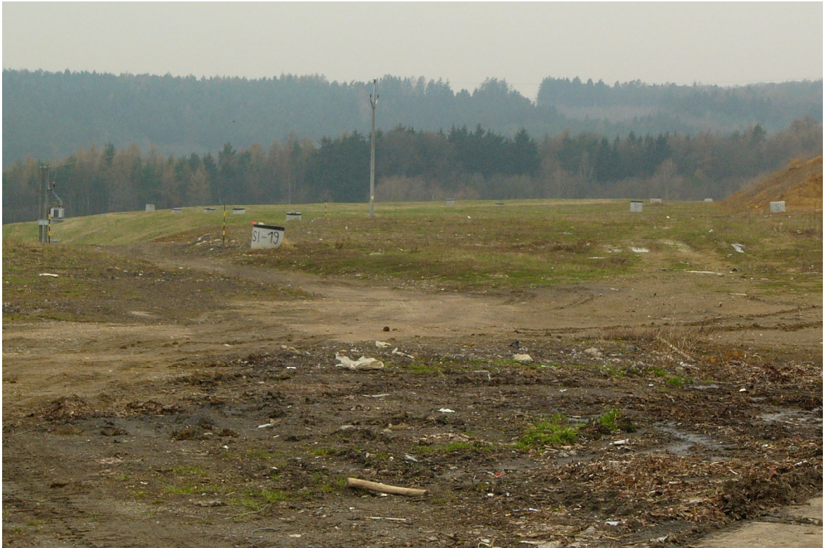
Obrázek 9: odplyňovací studny na již uzavřené I. etapě skládky
